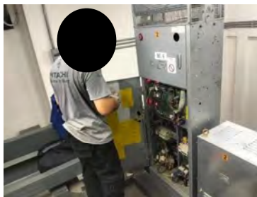
การตรวจสอบสภาพสายไฟหลักของอาคาร และอุปกรณ์ไฟฟ้าบริเวณพื้นที่ส่วนกลาง
