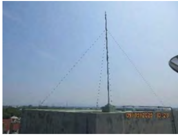
ระบบป้องกันฟ้าผ่า (ระบบป้องกันฟ้าผ่าแบบสายล่อฟ้า)
