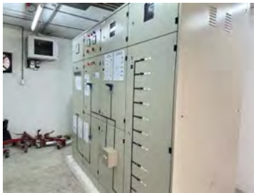
ภาพที่ 2-11 ระบบตัดกระแสไฟฟ้าอัตโนมัติ
